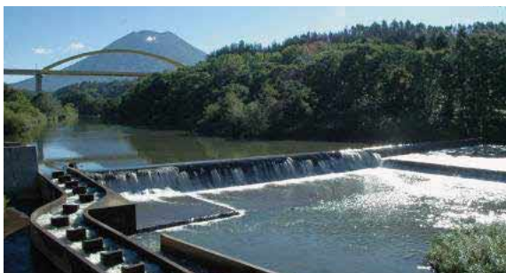
■住民団体の要望によって尻別川に設置された魚道
