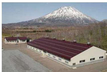
屋根がある一般廃棄物最終処分場 (手前が埋立施設、奥が水処理棟・トラックスケール)
